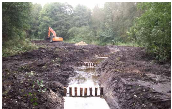
't Plat Aanleg vistrap
