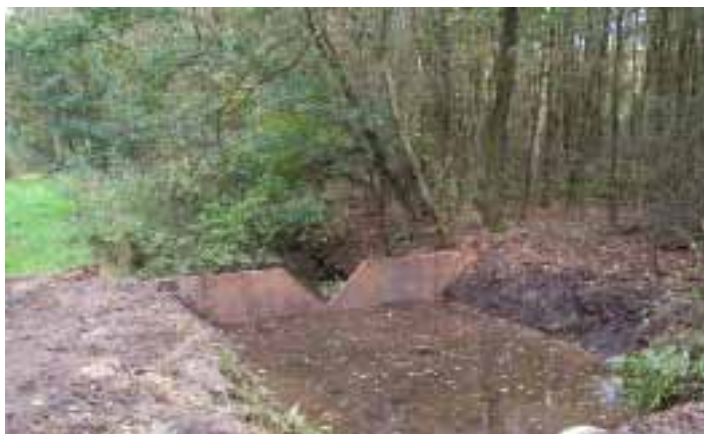
't Plat Sluis aan dijk
